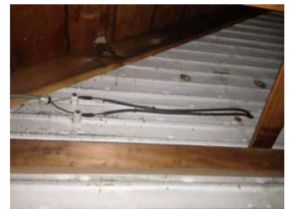
DS-11 Knob & tube wiring
